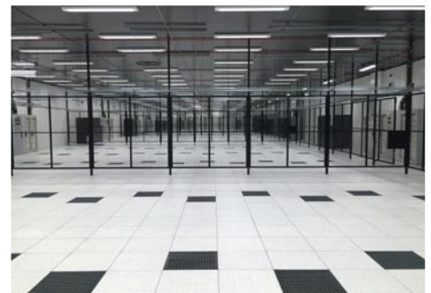
Installation d'un plancher de 3000 m 2
